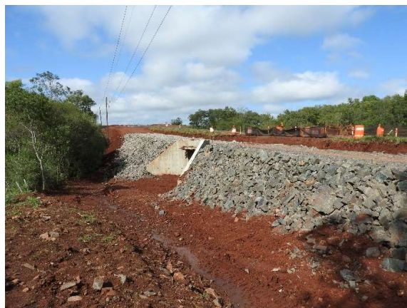
Figura 5 y Figura 6 – Construcción de pasafauna en PR 17+500. Agosto 2022.
