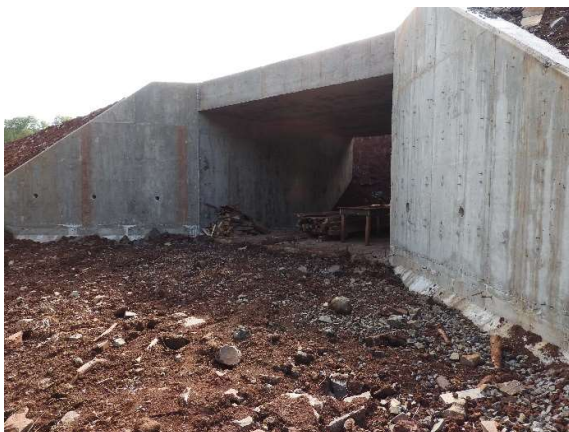
Figura 5 y Figura 6 – Construcción de pasafauna en PR 17+500. Agosto 2022.
